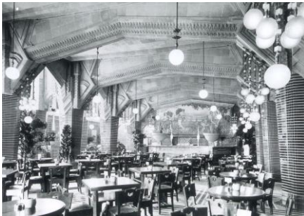
昭和9年竣工当時の様子
